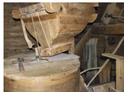
Locali con presenza di roditori Premises with the presence of rodents
