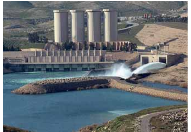
Musul Barajı Mosul Dam
